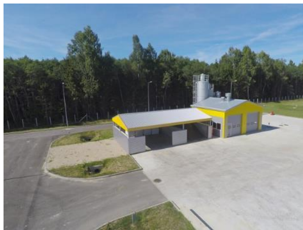
PA stabilizavimo įrenginiai
